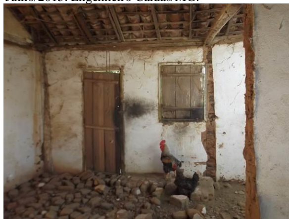
Foto 04: Vista parcial interna da sala, observa-se a parede arruinada do quarto. Fotógrafa: Fabiane Cristine Fonseca. Julho/2015. Engenheiro Caldas/MG.
