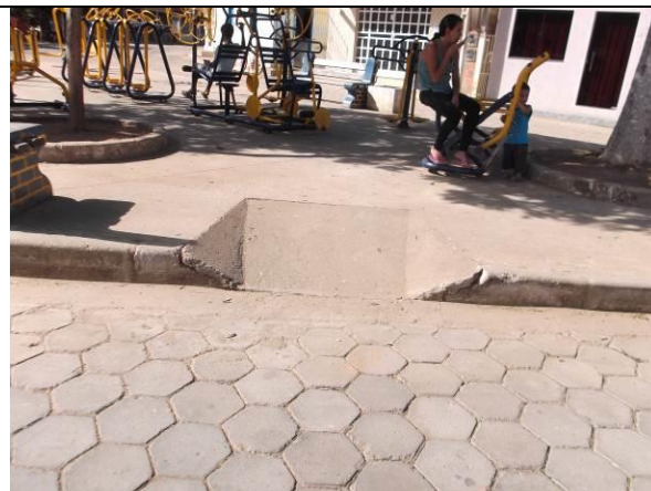
Foto 04: Rampa de acesso com inclinação superior ao recomendado pelas normas da ABNT. Fotógrafa: Fabiane Cristine Fonseca. Julho/2015. Engenheiro Caldas/MG.
