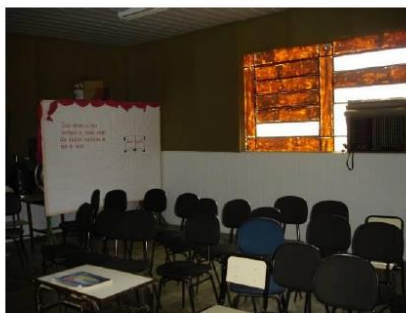
Foto 8: Sala de música (revestimento acústico em espuma)
