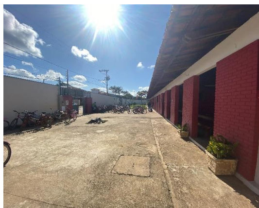
Foto 10 – Vista do interior do bem. Data: 10/08/2023. Autor (a): Andressa Damacena Carregosa.
