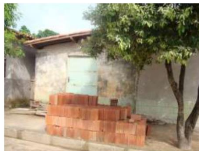
Vista frontal parcial
