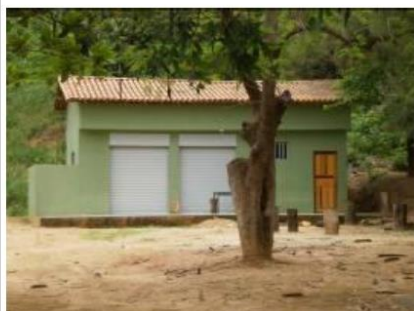
Foto 8: Cantina, nos fundos do campo
