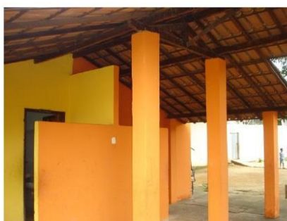
Foto 8: Área reformada e ampliada, onde se encontram os sanitários
