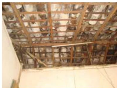
Estrutura de madeira do telhado
