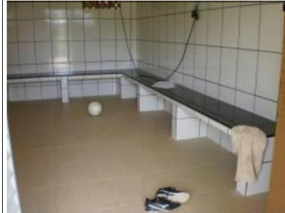
Foto 7: Interior de um dos vestiários.
