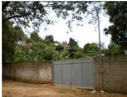
Foto 2: Vista interna muro e do portão maior
