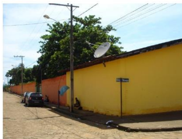
Foto 2: Vista do muro que cerca o prédio onde funciona a Escola Municipal Luzia de Oliveira Santos e parte do portão de entrada, na rua Curitiba
