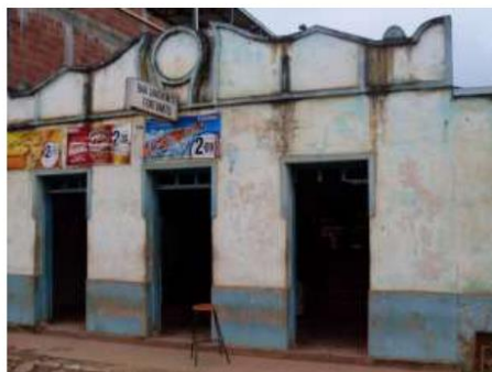
Foto 03- Vista frontal da antiga mercearia e posto telefônico.
