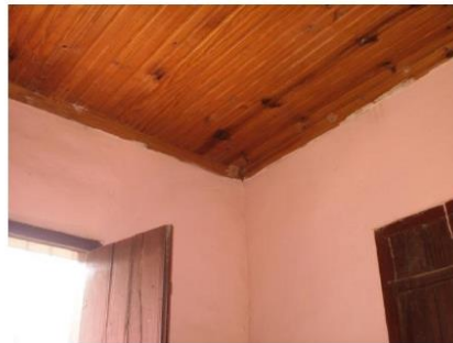
Foto 6: Detalhe do forro do teto, em madeira
