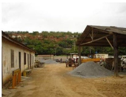
Foto 4: Vista do que era o pátio de recreação, hoje galpão de veículos, máquinas e materiais de construção
