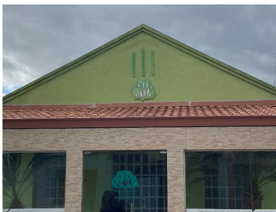
Foto 3 – Vista da fachada do bem. Data: 03/08/2022. Autor (a): Andressa Damacena Carregosa.
