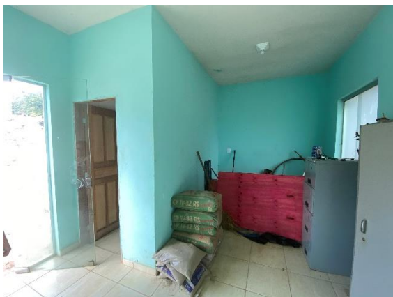
Foto 9 – Vista do interior da capela.
