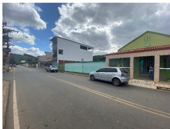
Foto 2 – Vista do entorno do bem.
