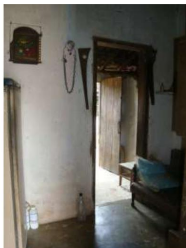
Piso de cimentado
