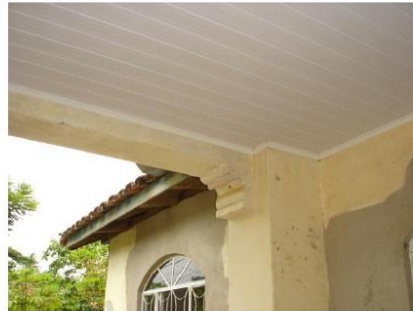
Foto 6: Detalhe da coluna na varanda e forro em PVC
