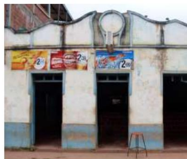
Foto 02 – Vista frontal da Mercearia e Antigo posto telefônico.
