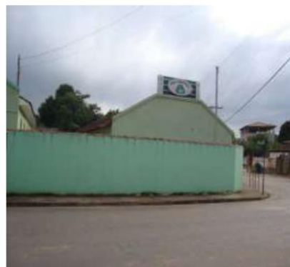
Muro e anexo.
