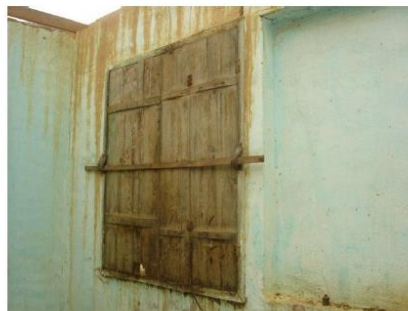
Foto 4: Vista interna da janela de um dos cômodos que já foi sala de aula
