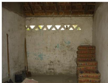
Foto 2: Vista interna de um dos cômodos onde eram as salas e hoje é depósito da Secretaria de Obras
