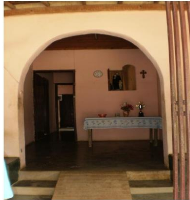
Foto 4: Entrada para a casa, com rampa que facilita o acesso de deficientes físicos
