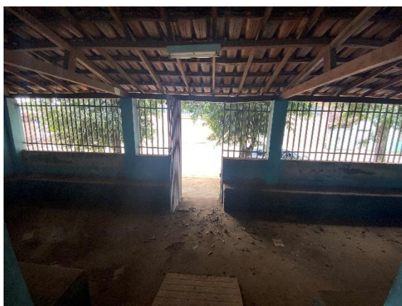
Foto 5 – Vista do interior do bem. Data: 10/08/2023. Autor (a): Andressa Damacena Carregosa.
