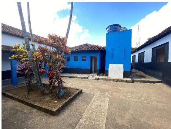
Foto 5 – Vista do interior do bem. Data: 10/08/2023. Autor (a): Andressa Damacena Carregosa.
