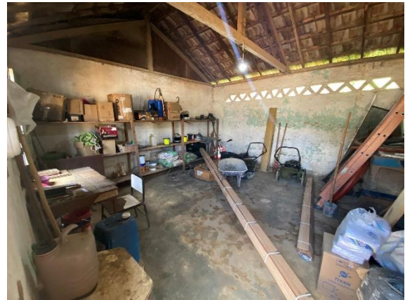
Foto 6 – Vista do interior do bem. Data: 10/08/2023. Autor (a): Andressa Damacena Carregosa.
