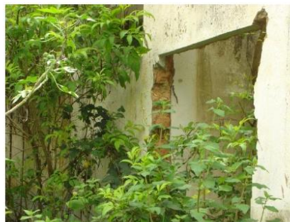
Foto 4: Foto do interior do posto
