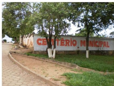
Foto 1: Vista do muro do Cemitério, na esquina das ruas Flores e Vista Alegre
