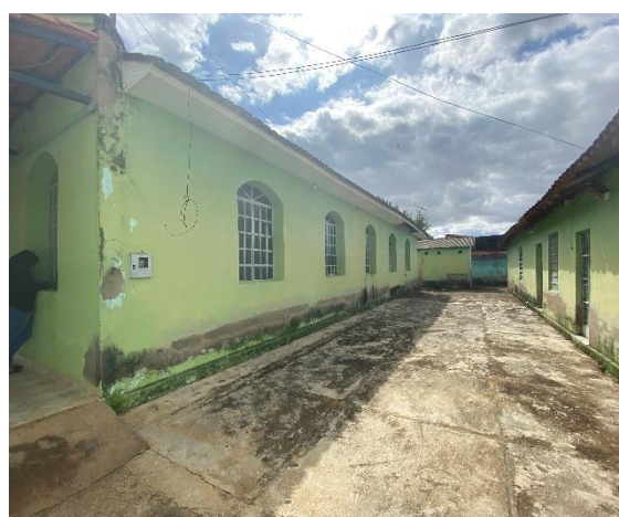
Foto 8 – Vista da fachada lateral e pátio. Data: 03/08/2022. Autor (a): Andressa Damacena Carregosa.
