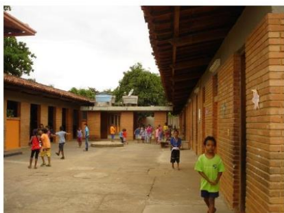
Foto 5: Vista para o pátio, entre os dois primeiros blocos construídos em
