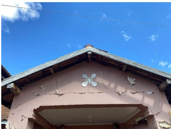
Foto 5 – Vista do detalhe da fachada. Data: 10/08/2023. Autor (a): Andressa Damacena Carregosa.
