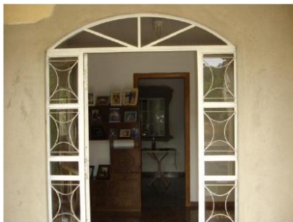
Foto 7: Porta de entrada da casa onde funcionava a pensão
