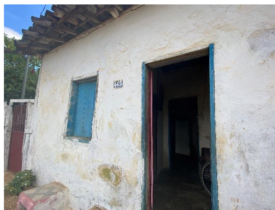
Foto 4 – Vista da fachada do bem. Data: 03/08/2022. Autor (a): Andressa Damacena Carregosa.
