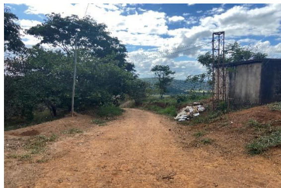
Foto 6 – Estrada de acesso ao bem.
