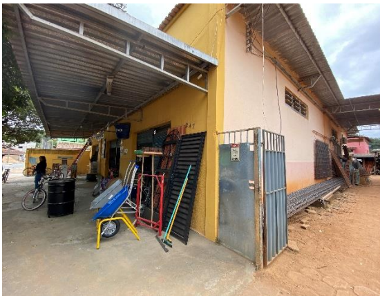
Foto 5 – Vista da fachada do bem. Data: 03/08/2022. Autor (a): Andressa Damacena Carregosa.
