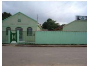
Fachada frontal e muro.
