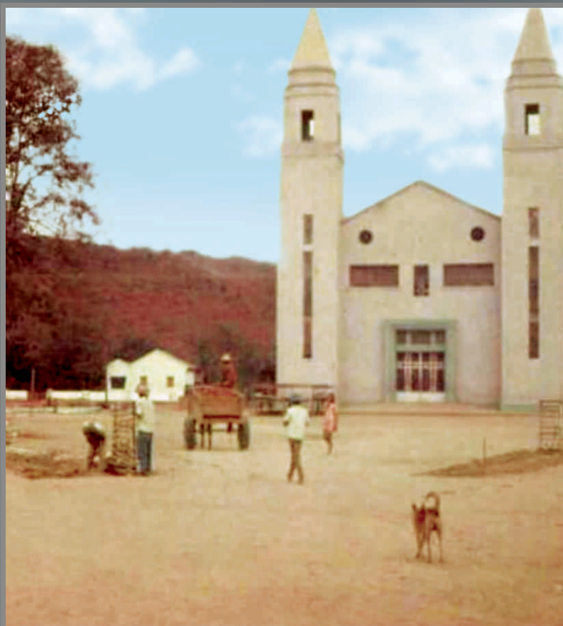
Calçamento da Praça Tancredo Neves
