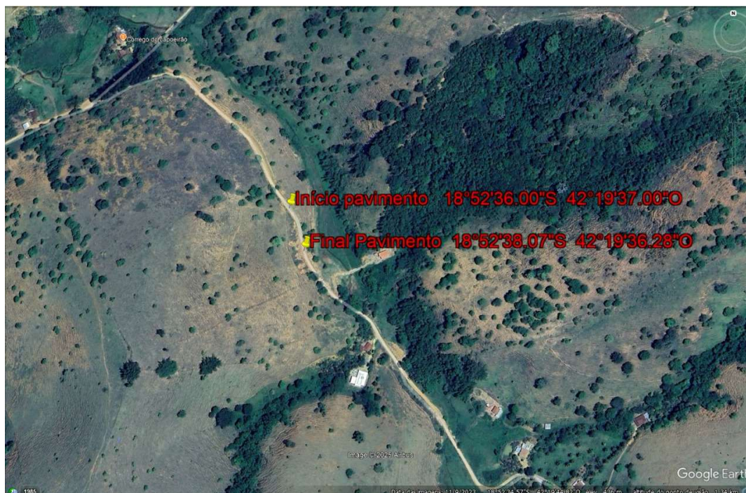
Figura 2 – Pavimentação do trecho da estrada de acesso as comunidades Capoeirão e Barrinha - Meta 02
