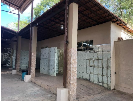
Foto 15 – Vista do acesso aos banheiros. Data: 20/08/2021. Autor: Lister Lucas R. Gonçalves.
