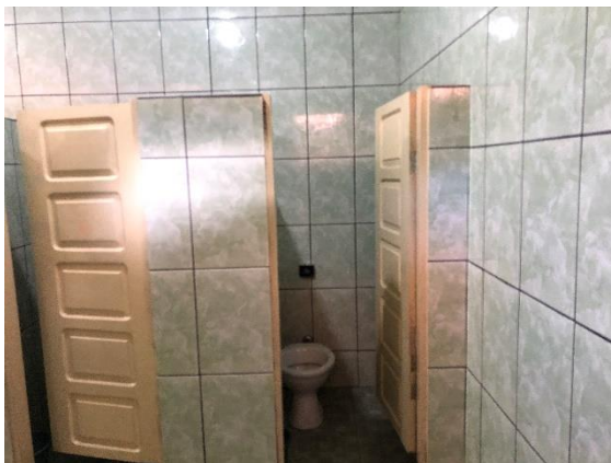
Foto 19 – Vista das portas dos sanitários. Data: 20/08/2021. Autor: Lister Lucas R. Gonçalves.
