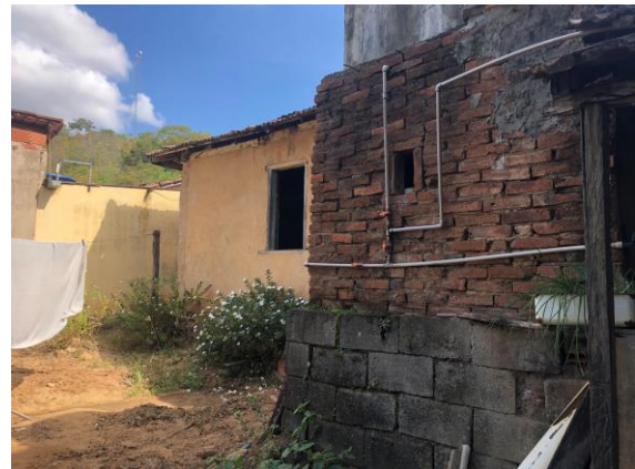
Foto 12 – Área externa do bem. Data: 20/08/2021. Autor: Lister Lucas R. Gonçalves.
