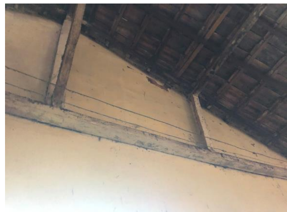
Foto 8 – Vista da estrutura do telhado do bem. Data: 20/08/2021. Autor: Lister Lucas R. Gonçalves.
