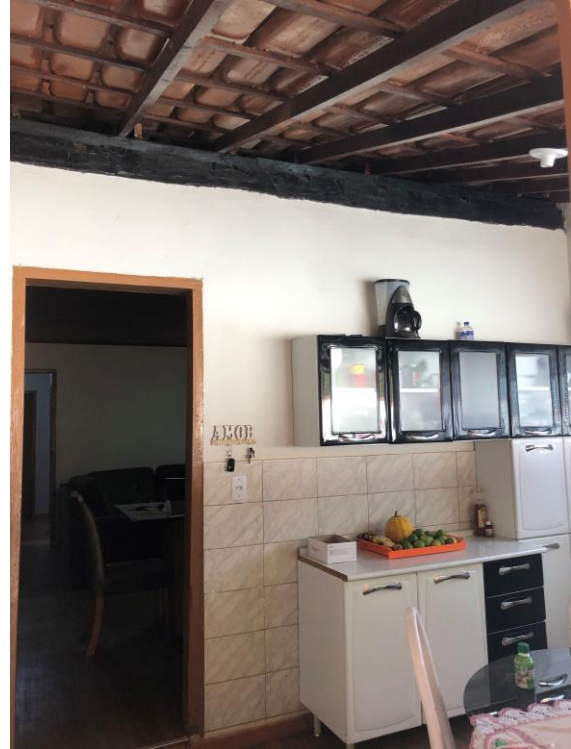
Foto 14 – Vista da copa e a entrada de acesso ao bem. Data: 20/08/2021. Autor: Lister Lucas R. Gonçalves.
