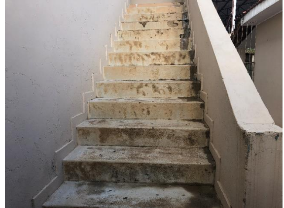
Foto 46 – escada de acesso. Data: 20/08/2021. Autor: Lister Lucas R. Gonçalves.
