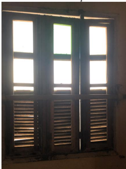
Foto 13 – Vista frontal da janela da residência.
