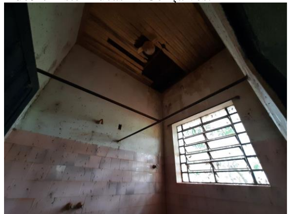
Foto 26 – Vista do forro do banheiro. Data: 21/10/2021. Autor: Lister Lucas R. Gonçalves
