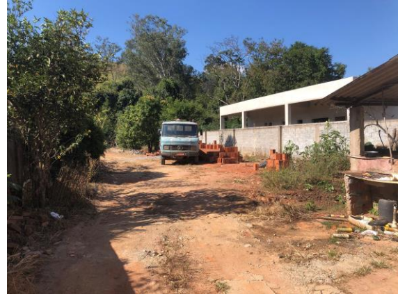
Foto 16 – Vista da área externa do bem.
