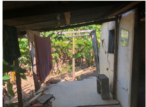
Foto 12 – Alpendre do bem imóvel. Data: 20/08/2021. Autor: Lister Lucas R. Gonçalves.
