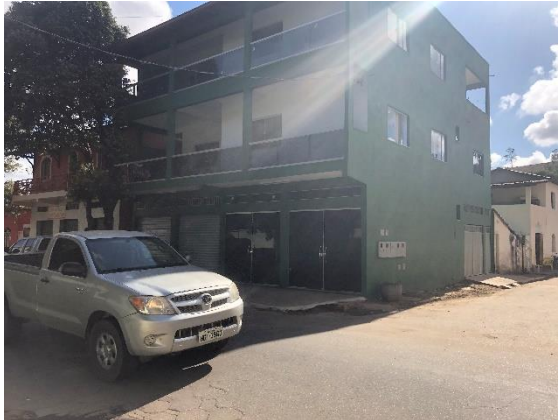
Foto 3 – Vista parcial do entorno do bem. Data: 20/08/2021. Autor: Lister Lucas R. Gonçalves.
