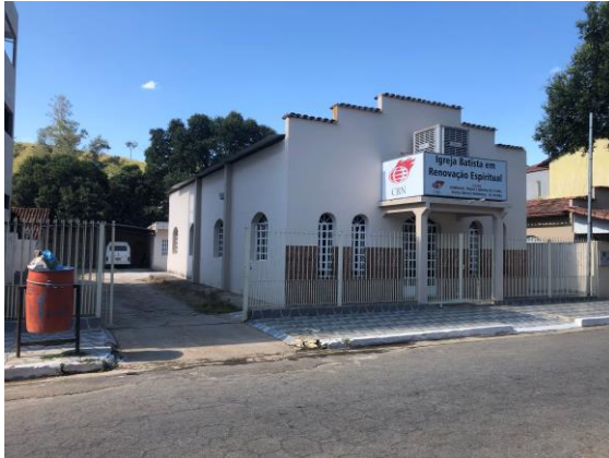
Foto 3 – Vista parcial da igreja.
