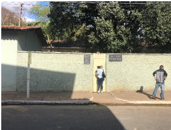
Foto 5 – Vista da fachada da escola. Data: 20/08/2021. Autor: Lister Lucas R. Gonçalves
