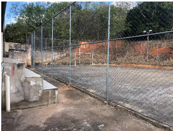
Foto 53 – Vista parcial da quadra da escola.
