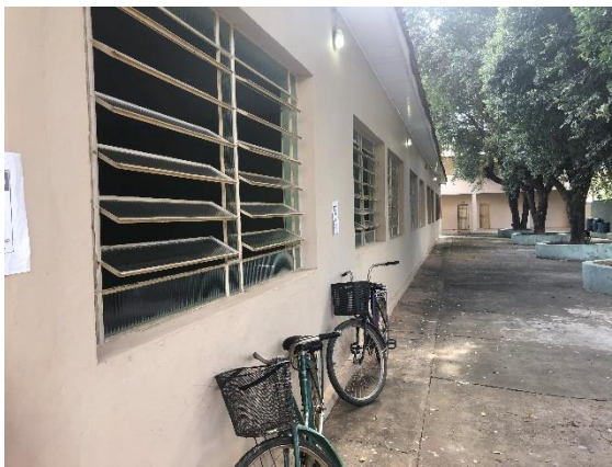
Foto 35 – Vista das janelas padrão das salas de aula. Data: 20/08/2021. Autor: Lister Lucas R. Gonçalves.
