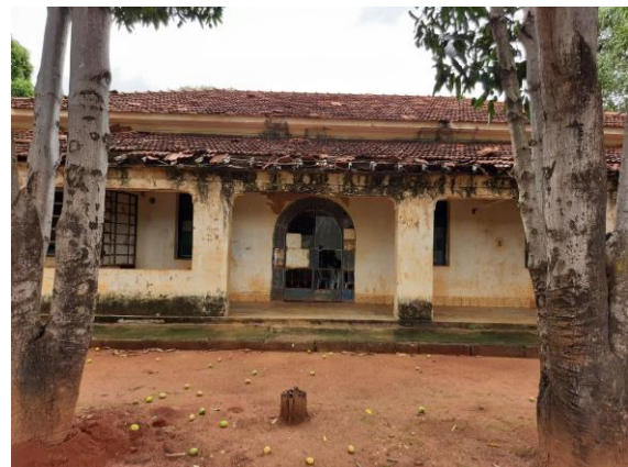
Foto 8 – Entrada da fachada posterior.
