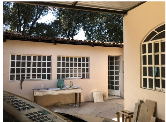
Foto 14 – Vista do anexo da igreja. Data: 20/08/2021. Autor: Lister Lucas R. Gonçalves.
