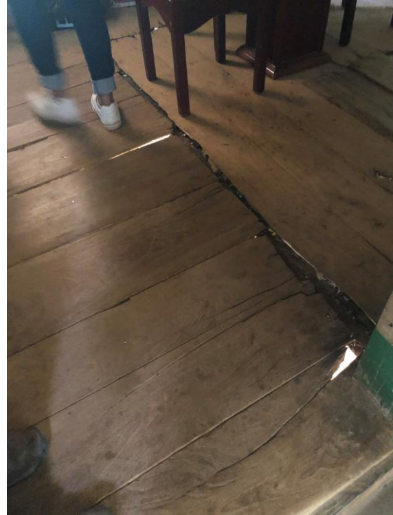
Foto 14 – Piso de tábua corrida.
