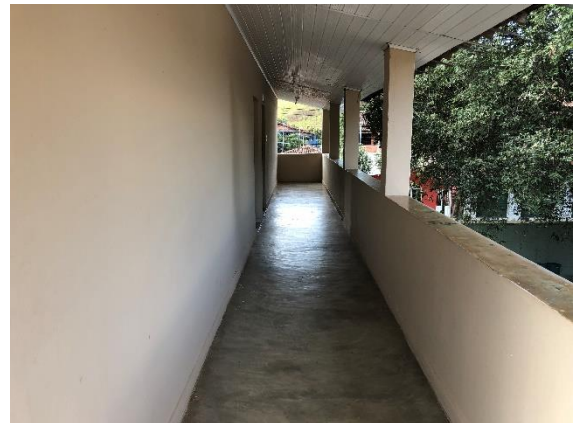
Foto 48 – Corredor de acesso as salas de aula. Data: 20/08/2021. Autor: Lister Lucas R. Gonçalves.
