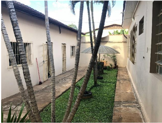
Foto 33 – Vista da área externa que separa as salas de aula da escola. Data: 20/08/2021. Autor: Lister Lucas R. Gonçalves.
