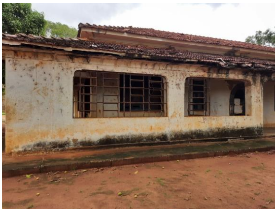
Foto 7 – Janelas da fachada posterior.
