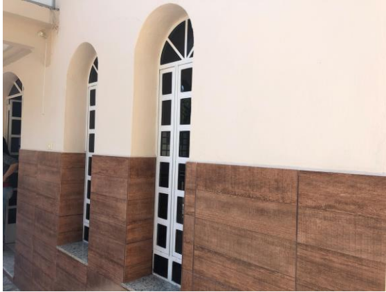
Foto 9 – Janelas padrão da igreja Data: 20/08/2021. Autor: Lister Lucas R. Gonçalves.
