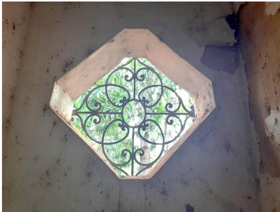
Foto 29 – Janela única na edificação. Data: 21/10/2021. Autor: Lister Lucas R. Gonçalves.
