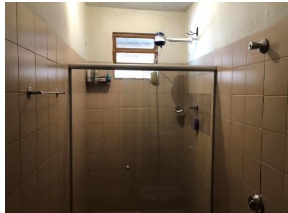
Foto 20 – Vista do banheiro da casa. Data: 20/08/2021. Autor: Lister Lucas R. Gonçalves.
