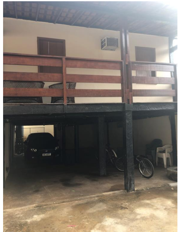
Foto 8 – Vista da garagem do bem. Data: 20/08/2021. Autor: Lister Lucas R. Gonçalves.
