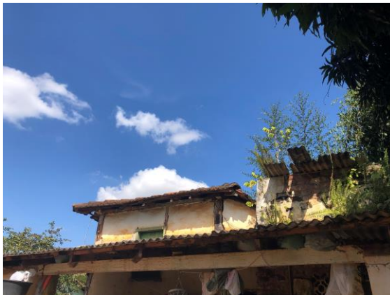
Foto 5 – Estrutura superior do telhado da casa.
