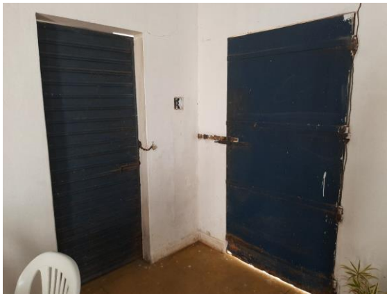
Foto 19 – Portas instaladas após intervenções. Data: 21/10/2021. Autor: Lister Lucas R. Gonçalves.
