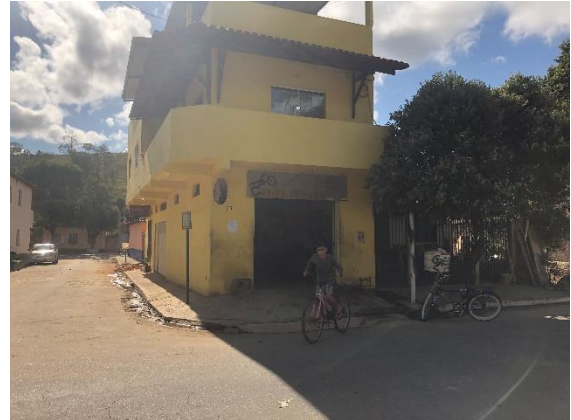
Foto 4 – Vista da rua em frente ao bem. Data: 20/08/2021. Autor: Lister Lucas R. Gonçalves.
