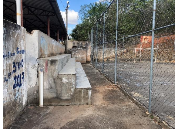
Foto 52 – Vista de uma parte da arquibancada.
