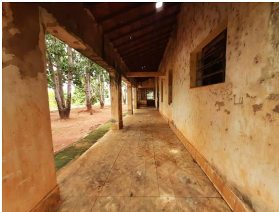
Foto 11 – Corredor da fachada posterior. Data: 21/10/2021. Autor: Lister Lucas R. Gonçalves.
