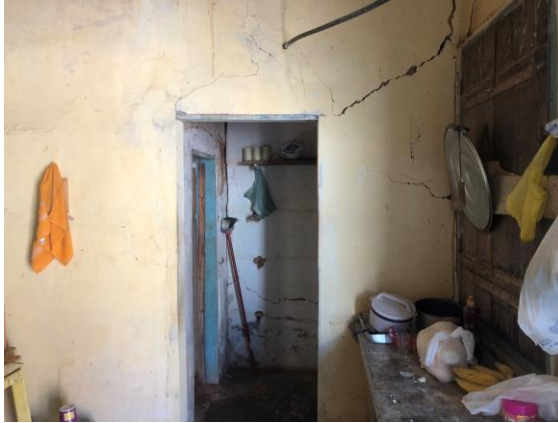
Foto 9 – Vista interna da área de serviço do bem.
