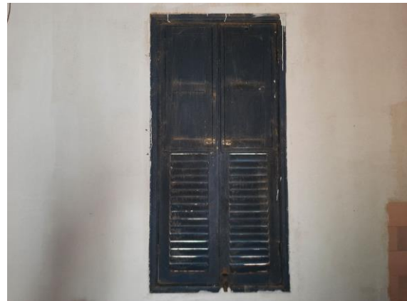
Foto 20 – Janela original do bem. Data: 21/10/2021. Autor: Lister Lucas R. Gonçalves.
