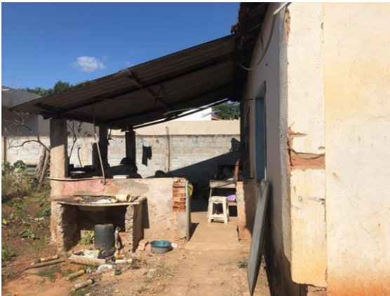
Foto 5 – Vista do alpendre. Data: 20/08/2021. Autor: Lister Lucas R. Gonçalves.
