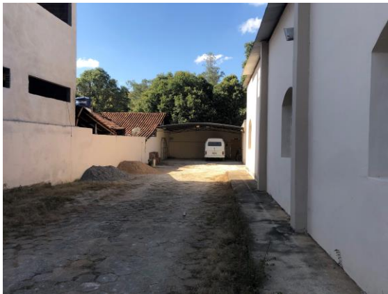
Foto 11 – Área externa da Igreja. Data: 20/08/2021. Autor: Lister Lucas R. Gonçalves.
