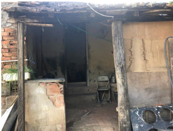
Foto 13 – Vista parcial da área de serviço. Data: 20/08/2021. Autor: Lister Lucas R. Gonçalves.
