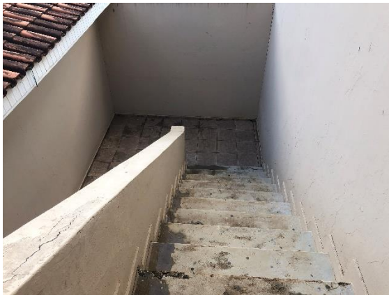
Foto 47 – Vista da escada de acesso ao andar superior da escola. Data: 20/08/2021. Autor: Lister Lucas R. Gonçalves.
