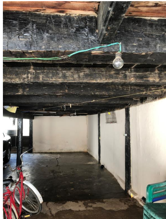
Foto 12 – Vista parcial da edificação. Data: 20/08/2021. Autor: Lister Lucas R. Gonçalves.
