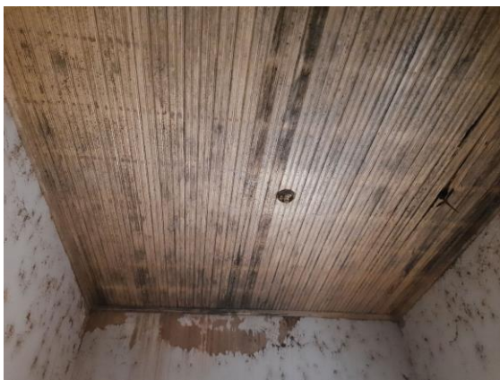
Foto 37 – Forro de um dos quartos que não estão sendo utilizados. Data: 21/10/2021. Autor: Lister Lucas R. Gonçalves.
