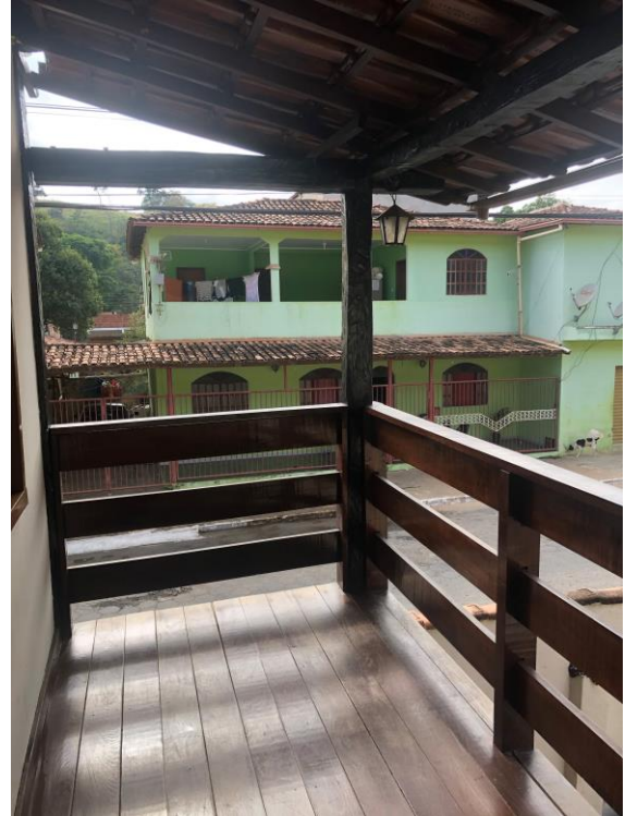
Foto 6 – Alpendre com vista em direção à rua. Data: 20/08/2021. Autor: Lister Lucas R. Gonçalves.
