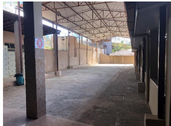
Foto 8 – Vista da área externa da escola. Data: 20/08/2021. Autor: Lister Lucas R. Gonçalves.
