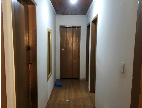
Foto 17 – Vista do corredor de acesso do bem. Data: 20/08/2021. Autor: Lister Lucas R. Gonçalves.
