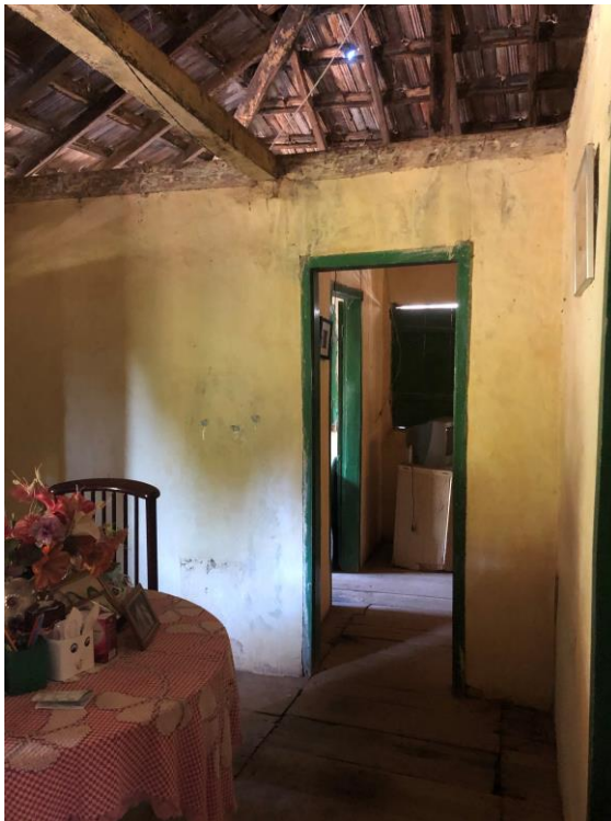
Foto 11 – Sala de estar da casa.
