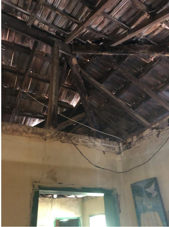
Foto 9 – Vista interna do telhado principal da casa.
