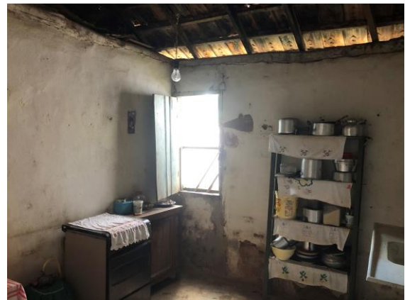
Foto 6 – Vista da cozinha.
