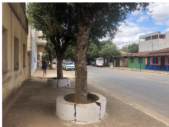
Foto 2 – Vista parcial da calçada e entorno do bem. Data: 20/08/2021. Autor: Lister Lucas R. Gonçalves.
