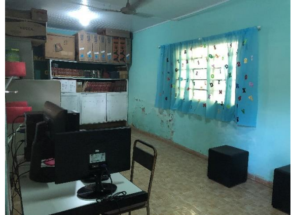
Foto 22 – Sala de arquivos da escola. Data: 20/08/2021. Autor: Lister Lucas R. Gonçalves.
