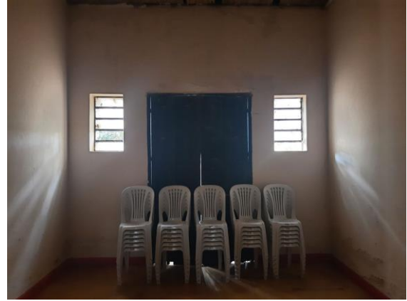
Foto 28 – Porta de acesso lateral. Data: 21/10/2021. Autor: Lister Lucas R. Gonçalves.
