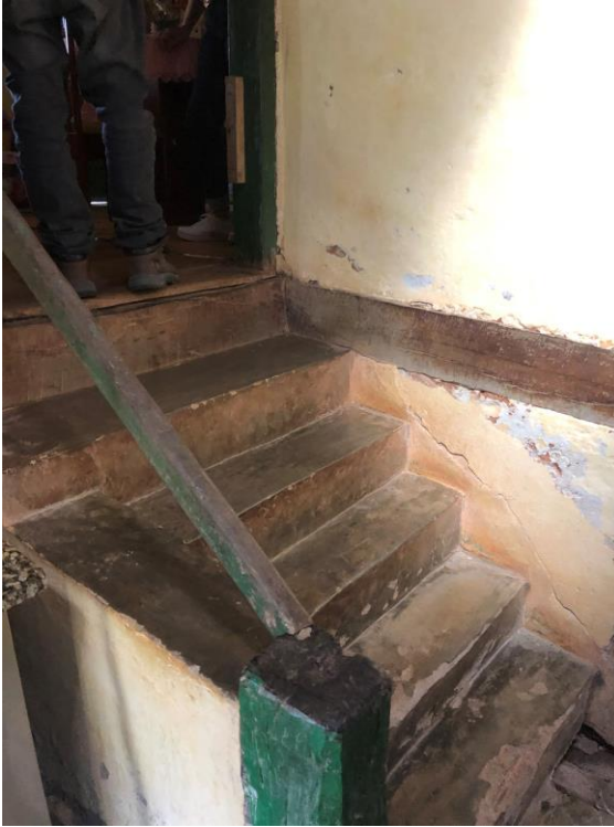
Foto 13 – Estrutura da escada de acesso ao bem.
