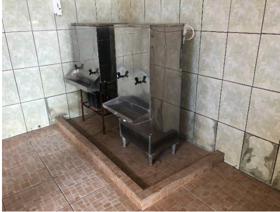
Foto 21 – Bebedouros da escola. Data: 20/08/2021. Autor: Lister Lucas R. Gonçalves.
