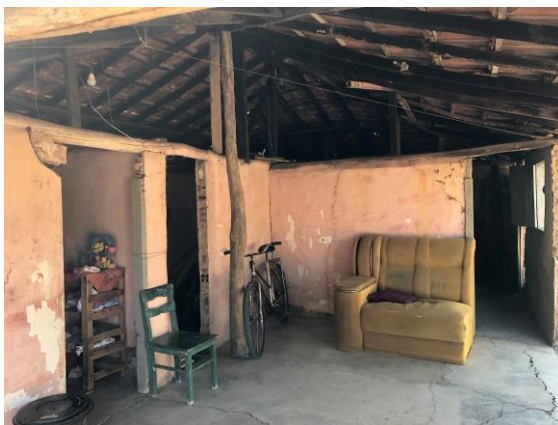
Foto 7 – Sala de estar da casa. Data: 20/08/2021. Autor: Lister Lucas R. Gonçalves.
