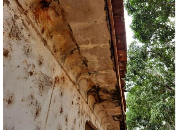
Foto 10 – Vista inferior do beiral. Data: 21/10/2021. Autor: Lister Lucas R. Gonçalves.
