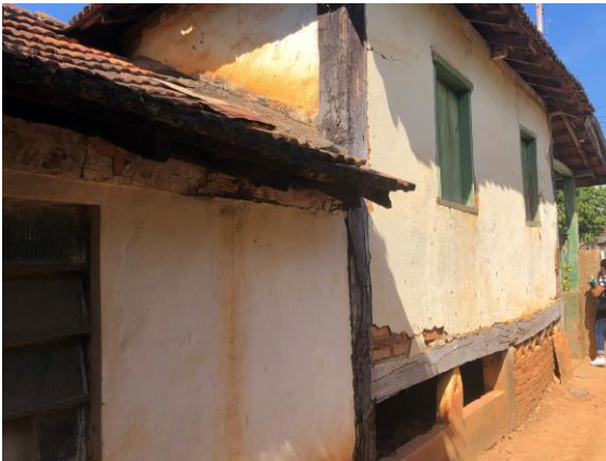
Foto 15 – Vista lateral do bem.
