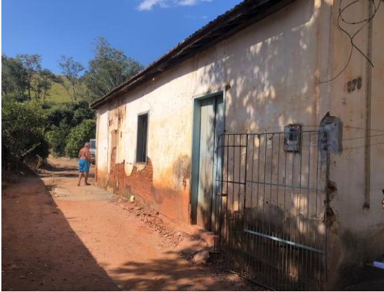
Foto 3 – Vista da lateral de acesso a casa. Data: 20/08/2021. Autor: Lister Lucas R. Gonçalves
