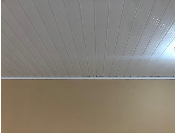
Foto 45 – Vista do forro do teto da biblioteca. Data: 20/08/2021. Autor: Lister Lucas R. Gonçalves.
