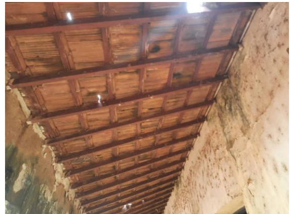
Foto 12 – Vista inferior do telhado do corredor. Data: 21/10/2021. Autor: Lister Lucas R. Gonçalves.
