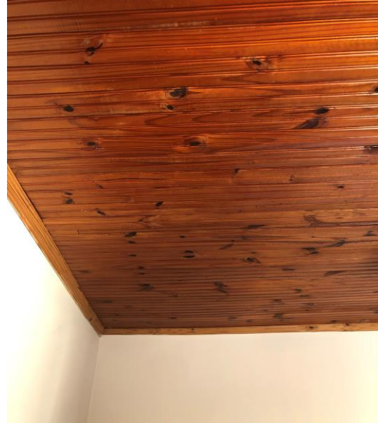
Foto 24 – Vista do forro do bem. Data: 20/08/2021. Autor: Lister Lucas R. Gonçalves.
