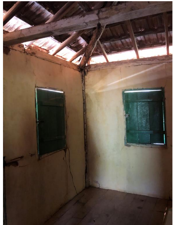
Foto 12 – Vista das janelas padrão do bem.
