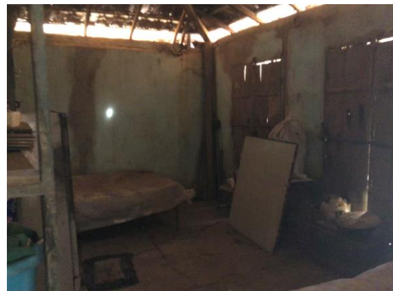
Foto 8 – Vista do quarto da residência.
