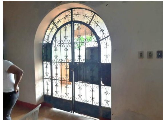
Foto 30 – Porta aos fundos da edificação. Data: 21/10/2021. Autor: Lister Lucas R. Gonçalves.
