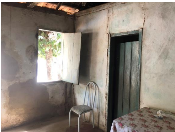
Foto 7 – Vista da copa da casa.
