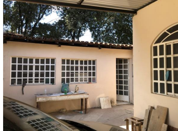
Foto 16 – Vista do anexo da igreja. Data: 20/08/2021. Autor: Lister Lucas R. Gonçalves.
