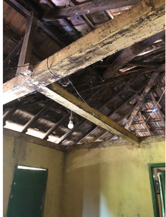
Foto 10 – Vista do telhado juntamente com a parte elétrica do bem.
