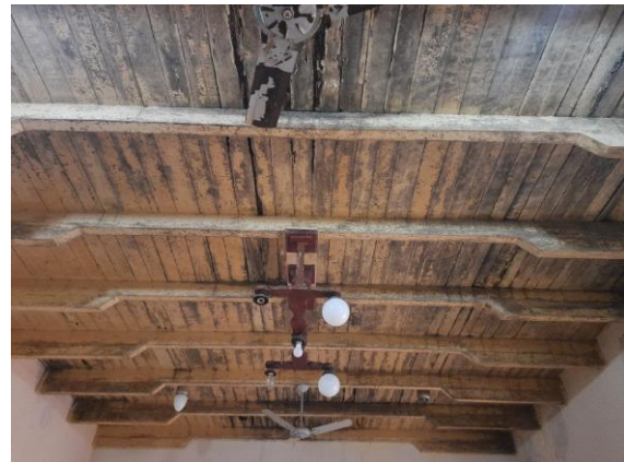
Foto 32 – Forro do salão ao fundos do bem. Data: 21/10/2021. Autor: Lister Lucas R. Gonçalves.
