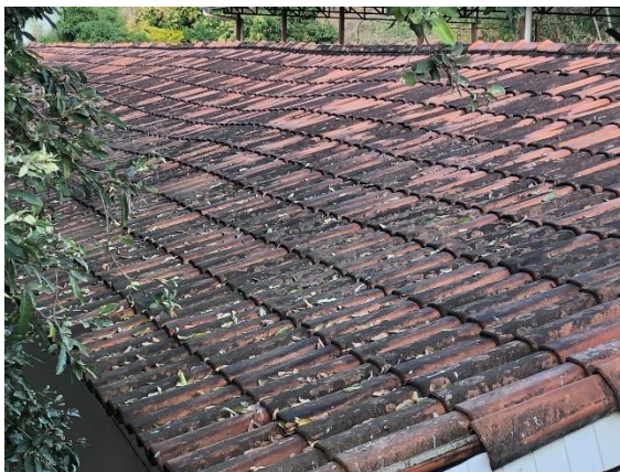
Foto 55 – Estrutura do telhado da escola.
