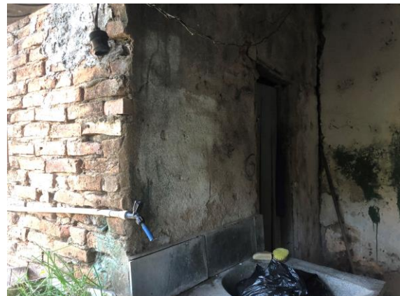
Foto 14 – Vista parcial da edificação. Data: 20/08/2021. Autor: Lister Lucas R. Gonçalves.
