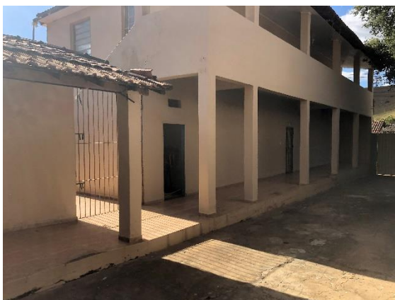
Foto 13 – Corredor de acesso as salas de aula. Data: 20/08/2021. Autor: Lister Lucas R. Gonçalves.
