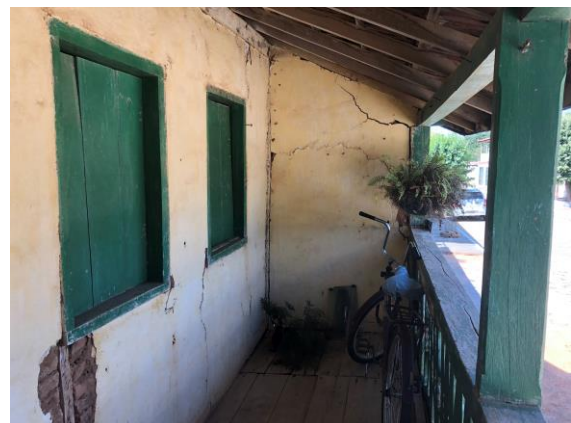
Foto 8 – Vista parcial do alpendre.
