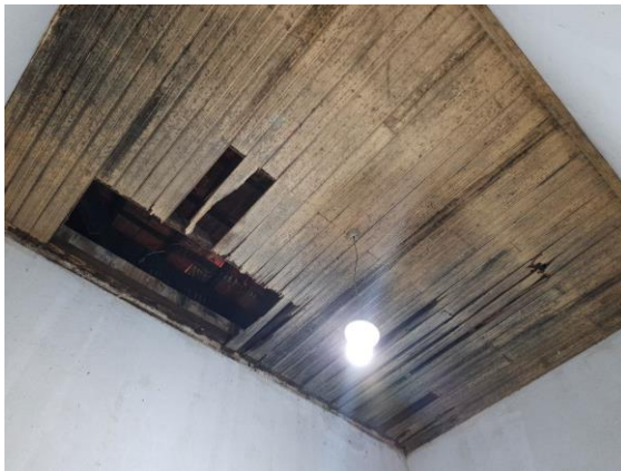
Foto 23 – Forro da sala administrativa. Data: 21/10/2021. Autor: Lister Lucas R. Gonçalves.
