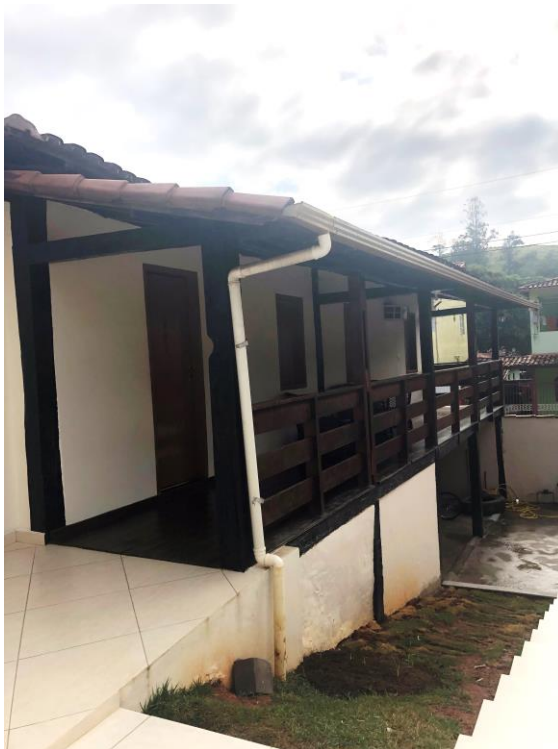
Foto 7 – Vista parcial do alpendre. Data: 20/08/2021. Autor: Lister Lucas R. Gonçalves.
