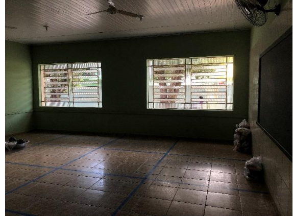
Foto 28 – Vista de uma das salas de aula. Data: 20/08/2021. Autor: Lister Lucas R. Gonçalves.
