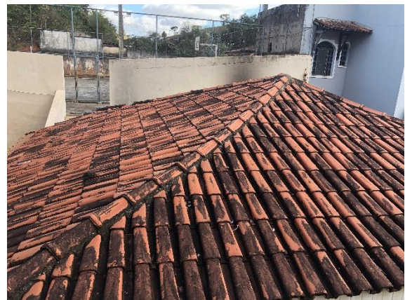
Foto 56 – Vista do telhado da escola.
