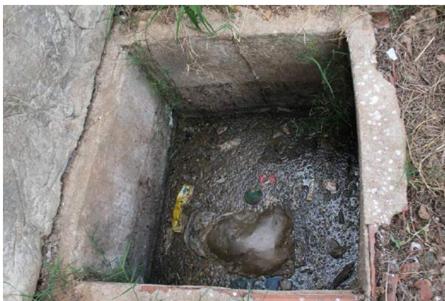
Figura 50 - Antiga Estação de Tratamento de Esgoto de Caçaratiba, ainda em funcionamento (setembro de 2.014).
