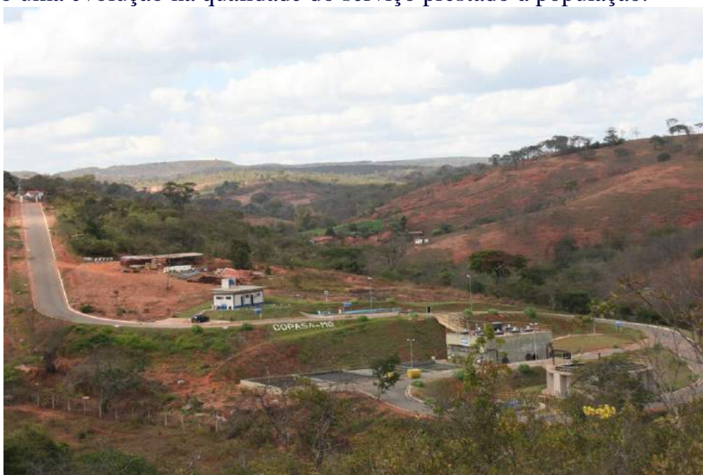
Figura 37 - Estação de tratamento de esgoto operada pela COPASA (setembro de 2.014)
