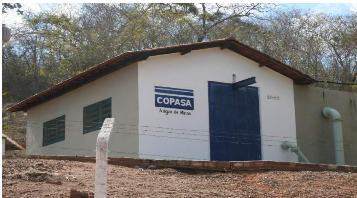
Figura 34 - Estação de Bombeamento da COPASA às margens do Rio Araçuaí – Município de Turmalina – MG (setembro de 2.014)
