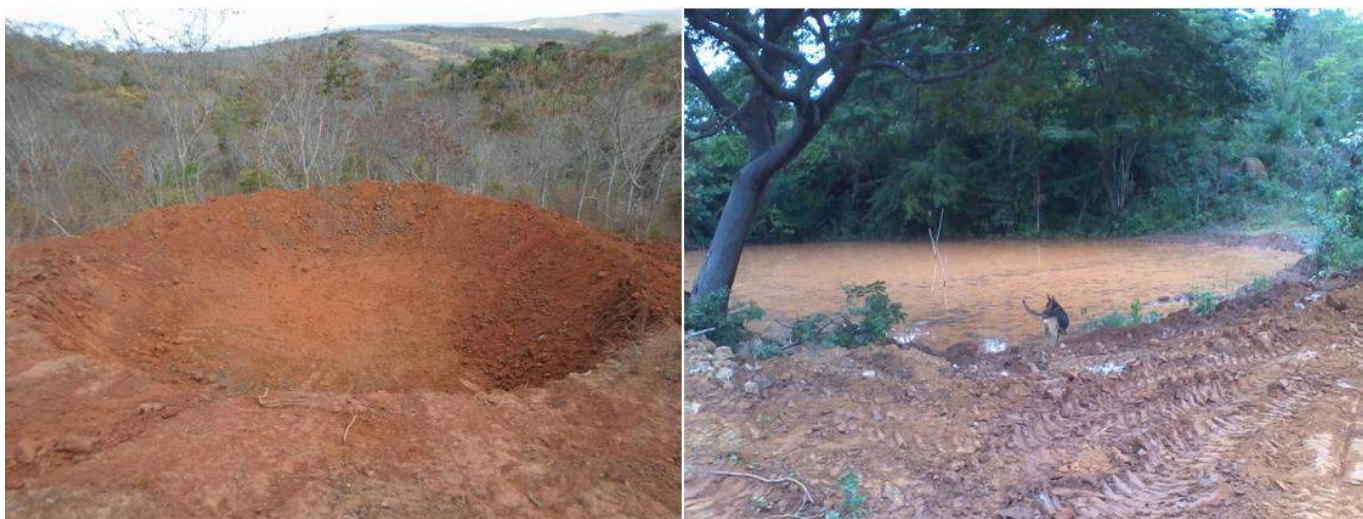
Figura 77 - Caixas de contenção de água, também chamadas de barraginhas (dezembro de 2.013)
