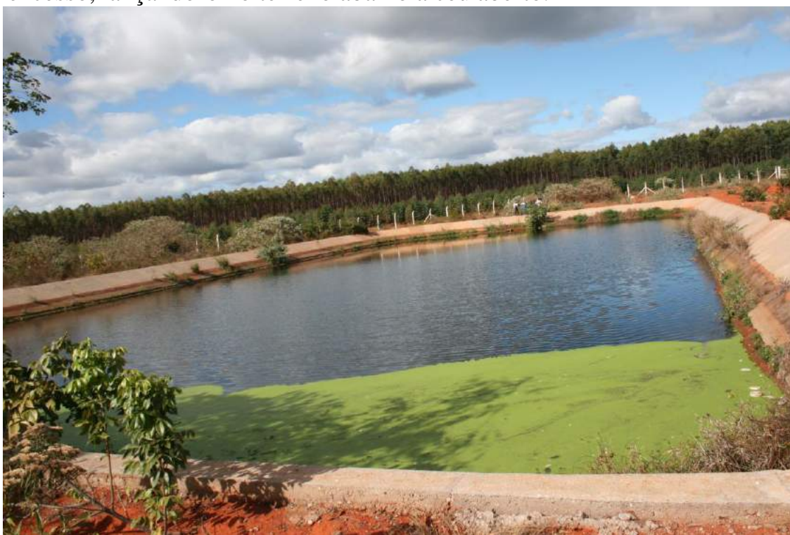
Figura 58 - Lagoa de Decantação de Resíduos sem tratamento no Povoado de Peixe Crú (setembro de 2014).
