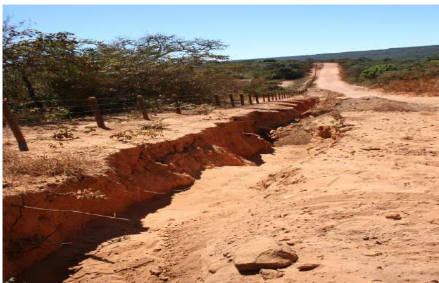
Figura 41 - Local conhecido como Lagoinha – Zona urbana do Município de Turmalina – Erosão provocada por águas pluviais não drenadas provenientes dos Bairros do Campo e S. João Batista (setembro de 2014).
