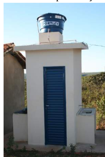
Figura 76 - Módulo Sanitário implantados no Município de Turmalina (setembro de 2.014)
