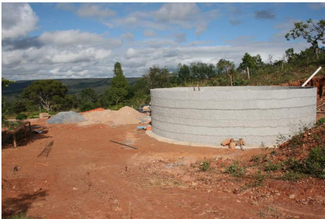
Figura 83 - Projeto Água do Lamba – Reservatório José David – Capacidade 100 m 3 - Turmalina - MG
