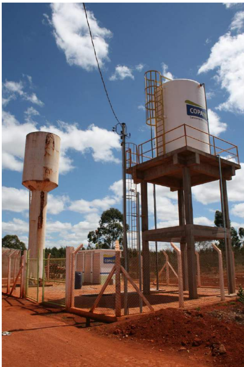
Figura 53 - Reservatórios de Água da Copanor no Povoado de Poço D'Antas (setembro de 2.014).
