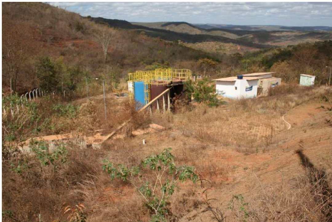
Figura 51 - Nova ETE de Caçaratiba - pronta e inoperante (setembro de 2.014)
