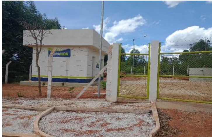
Figura 11 - ETA da Sede
