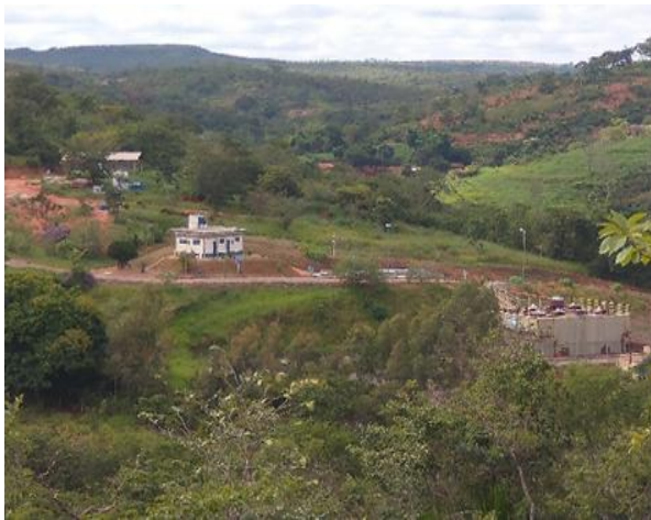
Figura 7 - ETE da sede
