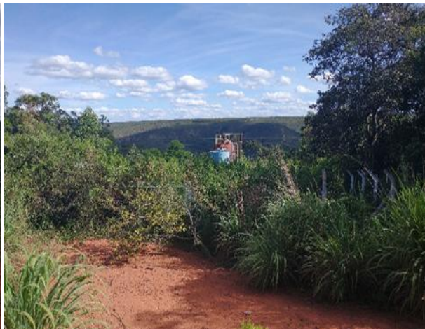
Figura 10 – ETE da Comunidade de Posto Dantas
